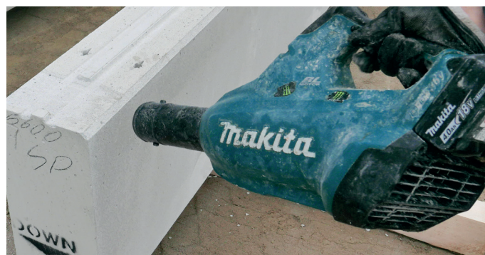
После фрезеровки очистить поверхность панели от мусора
